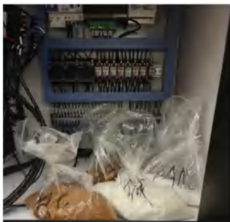
实验室污水处理设备（中和+沉淀）
