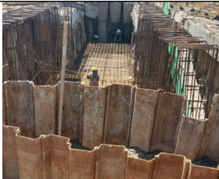
图 6-2 施工围堰
